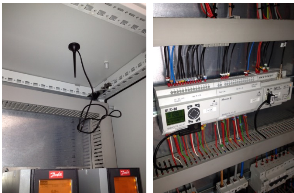
Figura 4: lado esquerdo: antena emissora. Lado direito: autômato e modem de gestão dos variadores de corrente.
