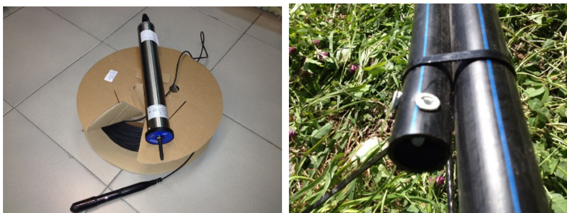
Figura 2: Lado esquerdo: sonda de pressão instalada no furo de captação e respectivo modem emissor. Lado direito: tubo guia e respectiva instalação da sonda de pressão.
